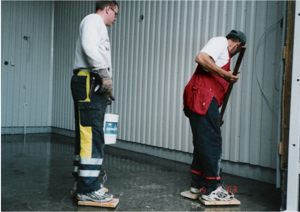
Kuva 13. Lattian pinnoituksessa Kari Pitkänen ja Tapani Lyytinen.
